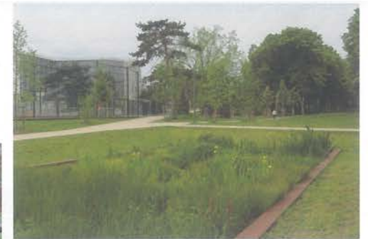
Un jardin en creux à la Cité internationale universitaire de Paris permet d'infiltrer les eaux pluviales et de développer un milieu végétal humide. (TN+)
