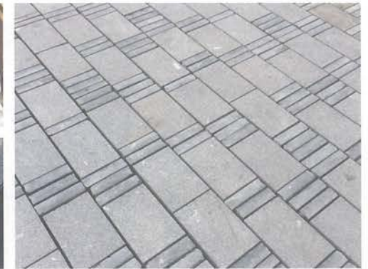
Parvis de Saint-Gilles à Bruxelles : 70 000 pavés de pierre bleue existants sur site sont réemployés, posés sur la tranche et associés à des pavés de granit. (Bureau Bas Smets)
