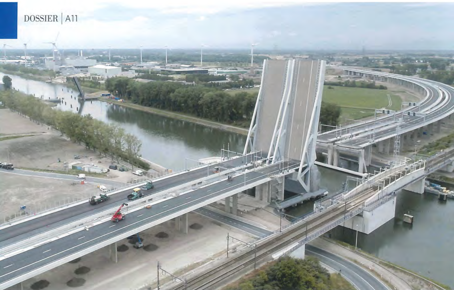
Het viaduct met de dubbele beweegbare brug over het Boudewijnkanaal is het gezicht van het project.
