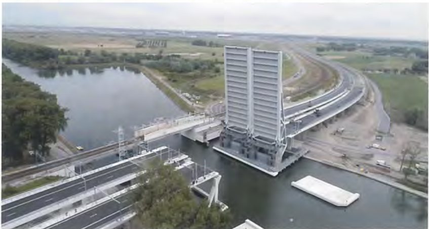
Een snelwegviaduct met een dubbele beweegbare brug: aan primeurs en technische hoogstandjes was er in het A11-project geen gebrek.
