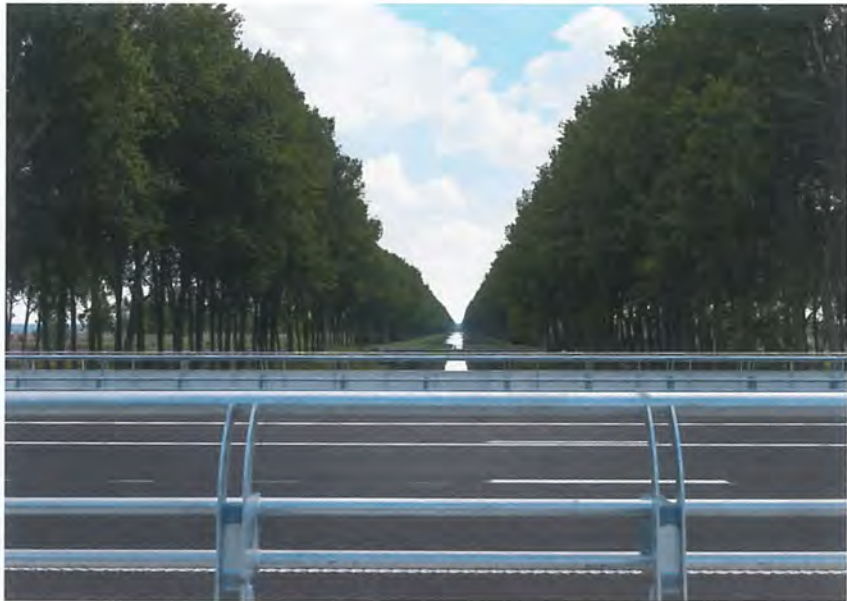
Het project behelsde niet enkel de bouw van een nieuwe snelweg, maar evenzeer de aanleg van lokale auto- en fietsverbindingen en tal van ingrepen met het oog op de landschappelijke inbedding van het geheel.
