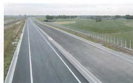
Tussen april en augustus van dit jaar werd nog 130.000 van de in totaal 300.000 ton asfalt aangelegd.
