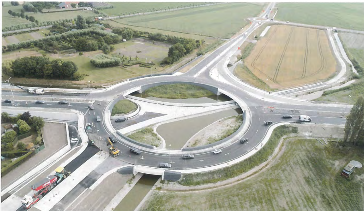
De realisatie van de A11 ging gepaard met de bouw van enkele ongelijkvloerse verkeerswisselaars.
