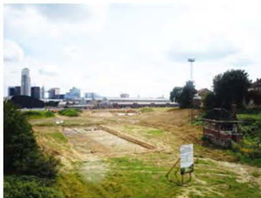
1, 2, 3 Vues du site Tour & Taxis en travaux/Views of the Tour & Taxis site in progress.
